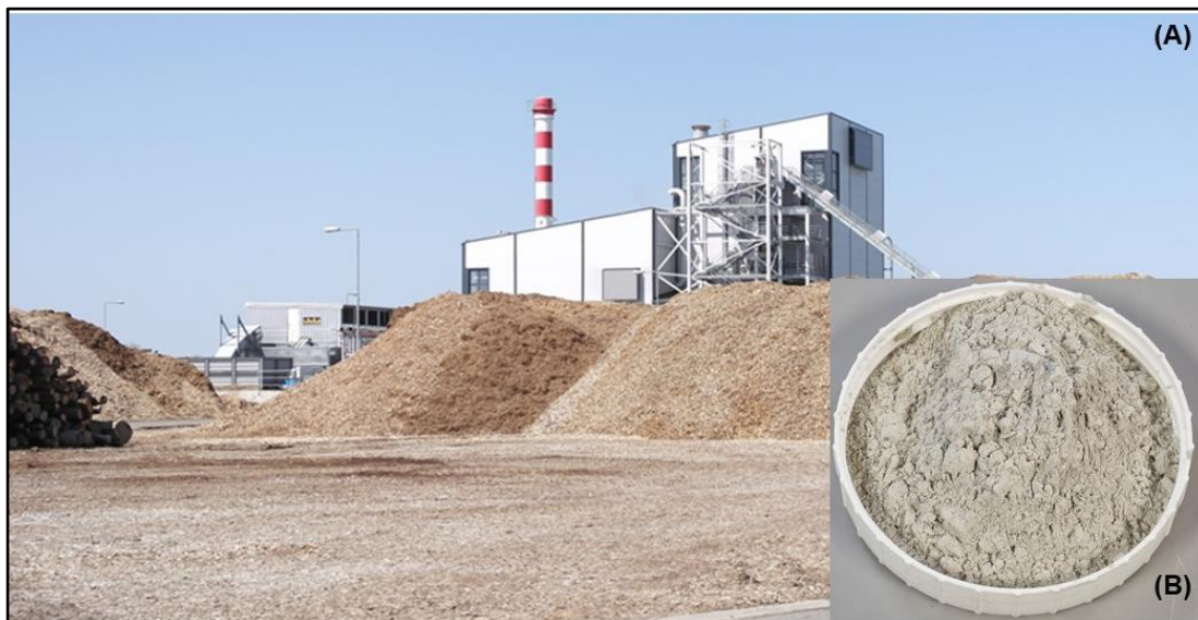
Slika 3.1. Termoelektrana „Uni Viridas“ u Babinoj Gredi s drvnom biomasom (sječkom) spremnom za spaljivanje (A), nusproizvod izgaranja biomase – lebdeći biopepeo (LB) spreman za aplikaciju(B) (Izvor: Ondrasek i sur., 2021).
