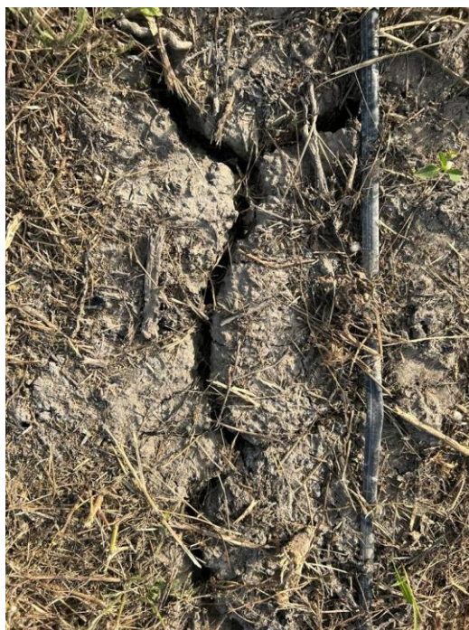
Slika 5.5. Pukotine na površini tla na LI Luke (Izvor: D. Romić)
