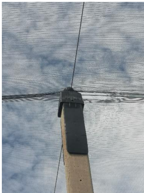
Slika 22. Prikaz kapica na vrhu stupova koje se koriste za postavljanje sajli - „flat net“ sistem
