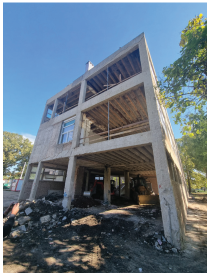
Ogoljena nosiva konstrukcija paviljona prije nastavka radova
