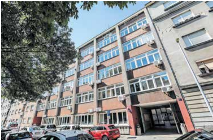
PRVI PUT U SEDAM DESETLJEĆA Zgrada FPZG-u temeljito će se obnoviti, kažu Zdenko Hrženjak iz tvrtke Graditelj svratišta, dekan Andrija Henjak i glavni nadzorni inženjer Mate Žagar
