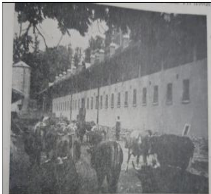
Relativno moderna, masivna štala. Ovakve se štale smatraju klasičnim prema starijem načinu gradnje (1930). Za onodobno shvaćanje tehničke opreme štale, zračnice su vrlo obilno izvedene (vertikalne i horizontalne stropne ventilacije). I na toj je štali prostran sjenik, ali ne onako masivno izveden, kao na prethodnoj slici (drvena izvedba obloga sjenika u nadgradnji nad stropom štale). Prozorska površina (na obje strane štale isti broj prozora) je dovoljna i iznosi oko 1/20 podne površine. (Kravska štala na F. D. Maksimir, Zagreb; Foto Smalcelj, 1938)
