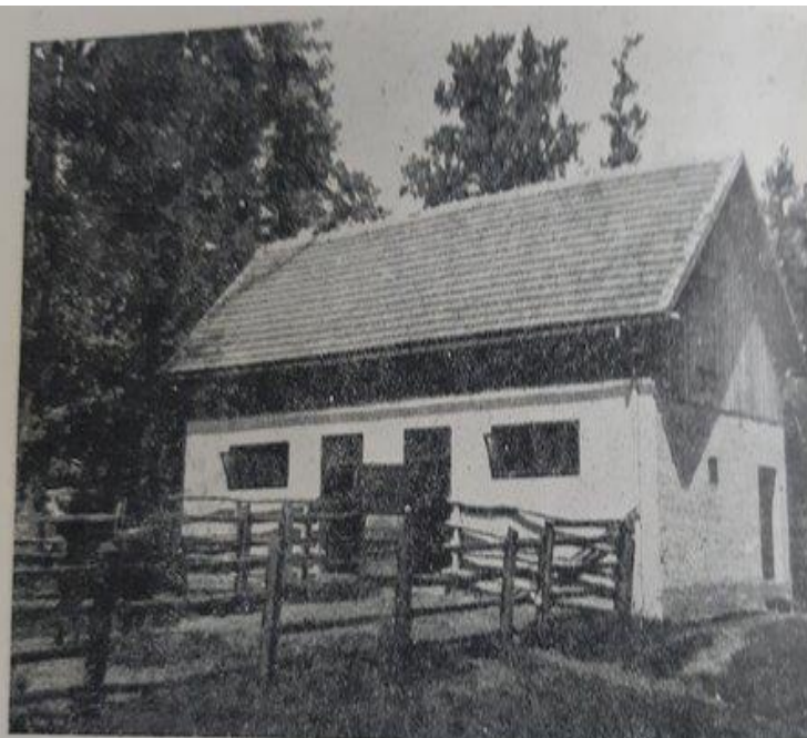
Bikovska štala na jednom većem dobru (F. D. Maksimir, Zagreb). Da s bikovima lakše ophodi, da budu mirniji i podvrgnuti posebnoj njezi, obično je, da se bikovi odvajaju iz kravske štale. Pred štalom je prostran ispasti za svakog bika posebno. Inače je raspored prostora sličan kao i u kravskoj štali.
