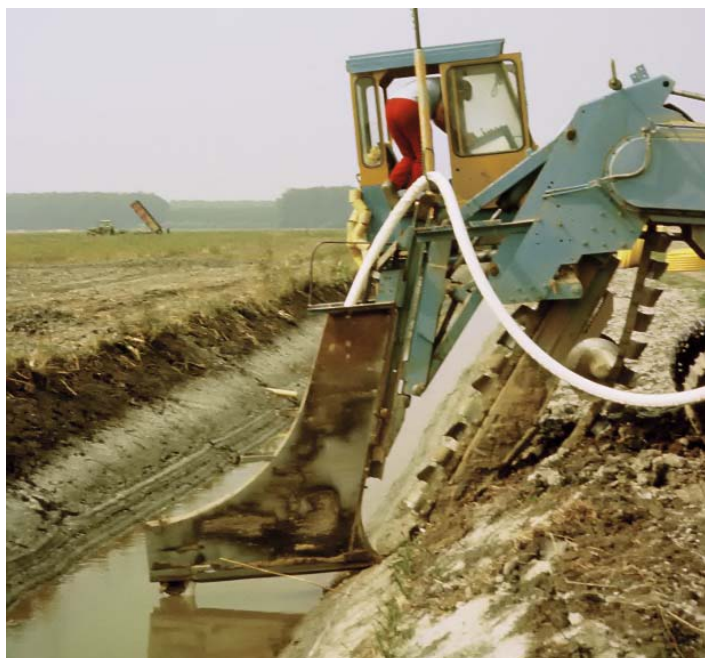
Slika 4.10. Izvođenje cijevne drenaže (Izvor: Arhiva Zavoda za melioracije)
