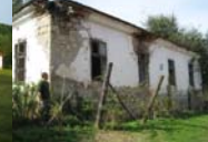
Fotografija: ruševno stanje objekta
